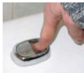
Chasse d'eau double flux
