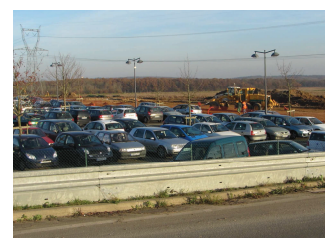
Les travaux vus depuis la route départementale
