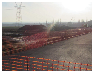
Les travaux en cours depuis le 18 novembre 2013
