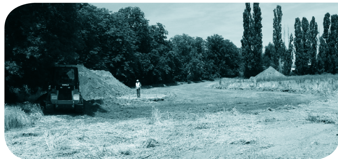
Début des travaux de l'Allée de l'ancienne ferme école
