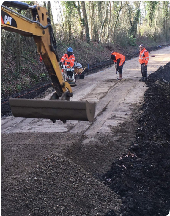
Travaux de la liaison douce intercommunale entre Boullay et la limite du 91 et du 78 (décembre 2019).
