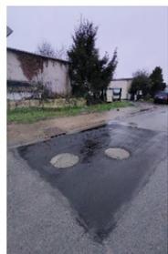
Poursuite des travaux pour la **Véloscénie**. En raison des trous provoqués par des blaireaux, une intervention a eu lieu pour combler l'effondrement de la chaussée.
