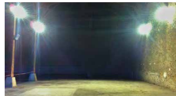
Réfection de l'éclairage de la ferme de Villezières à Saint-Jean de Beauregard
