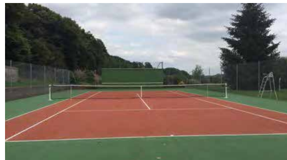
Rénovation d'un court de tennis à Courson-Monteloup
