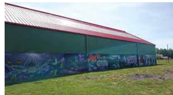
Rénovation de la toiture du tennis couvert à Saint-Maurice-Montcouronne
