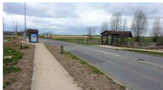
Réalisation d'une voie douce vers la véloscénie à Gometz-la-Ville
